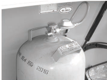
Abb. 68: Gasflasche mit Niederdruckregler und Niederdruckschlauch
