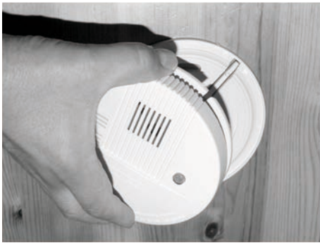
Abb. 161: Gehäuse abnehmen
