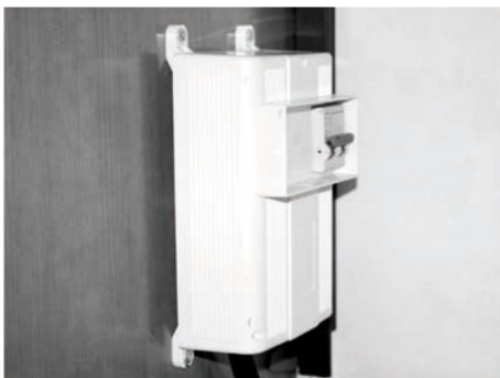
Abb. 57: Hauptschalter (FI-Schutzschalter)
